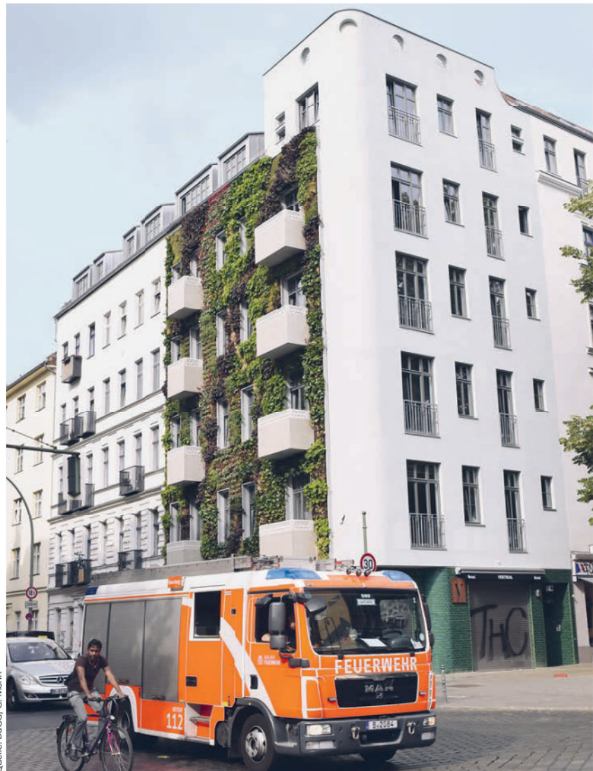
Auch die Fassaden höherer Wohngebäude können aus Sicht des Brandschutzes begrünt werden.
