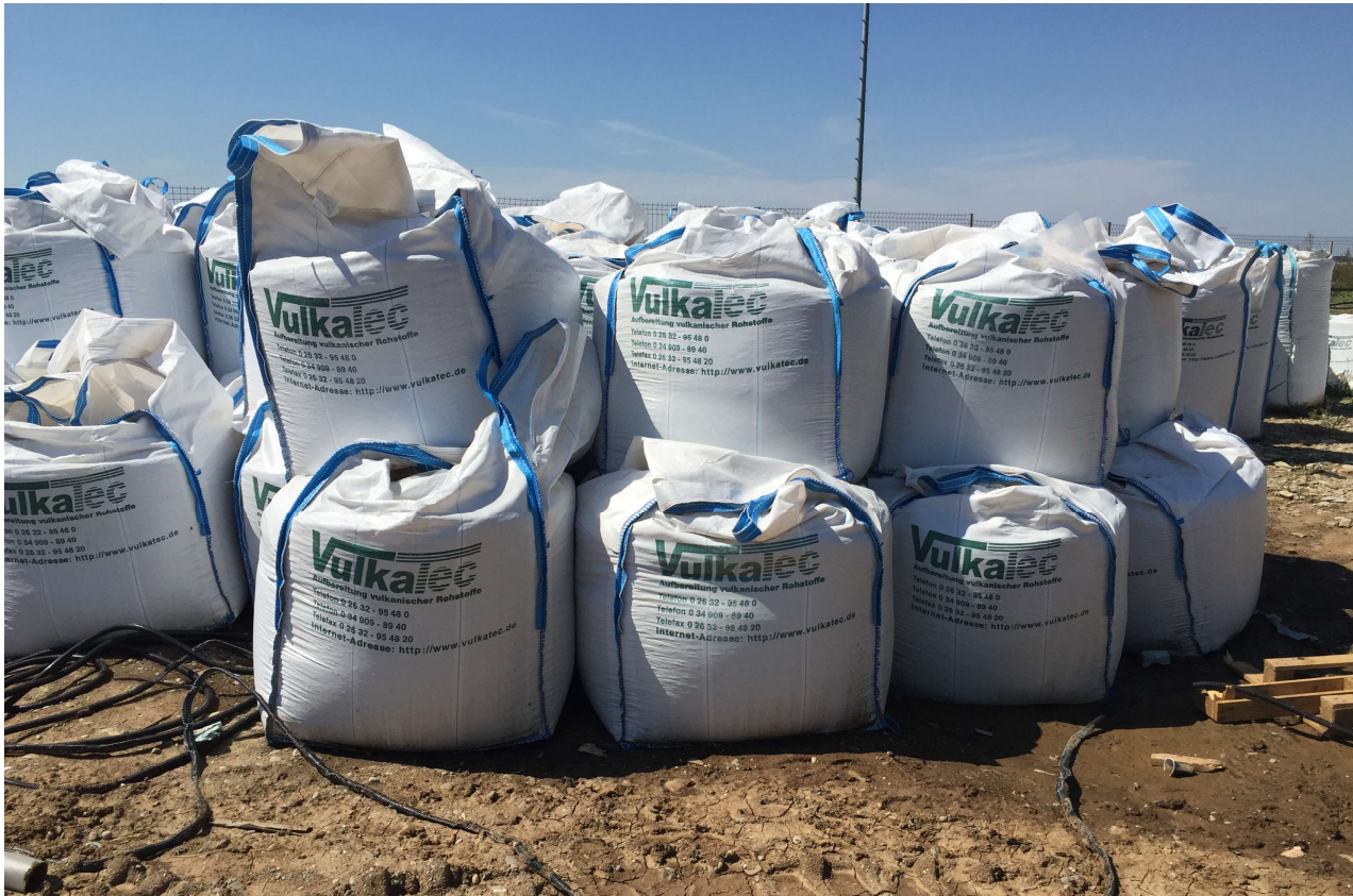
Einbau von 948 Big-Bags Spezialsubstrat
