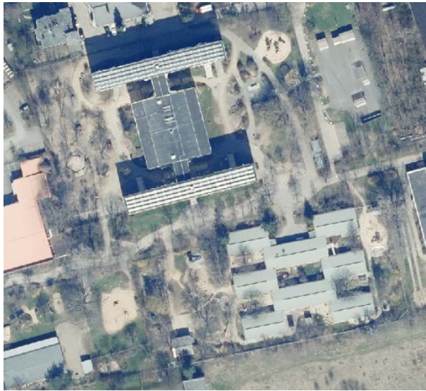
Bestandsgebäude KITA Weltentdecker Hallesche Straße, keine Begrünung
