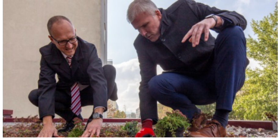
Friedrich-Engels-Straße, extensive Begrünung © Stadtverwaltung Erfurt Erfurt
