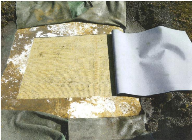
Extensive Begrünung, Trenn- und Schutzvlies, einlagige Abdichtung und trittfeste Mineralwolle: Von oben betrachtet sah das Dach bei den ersten Probeöffnungen „zunächst“ gut aus.
