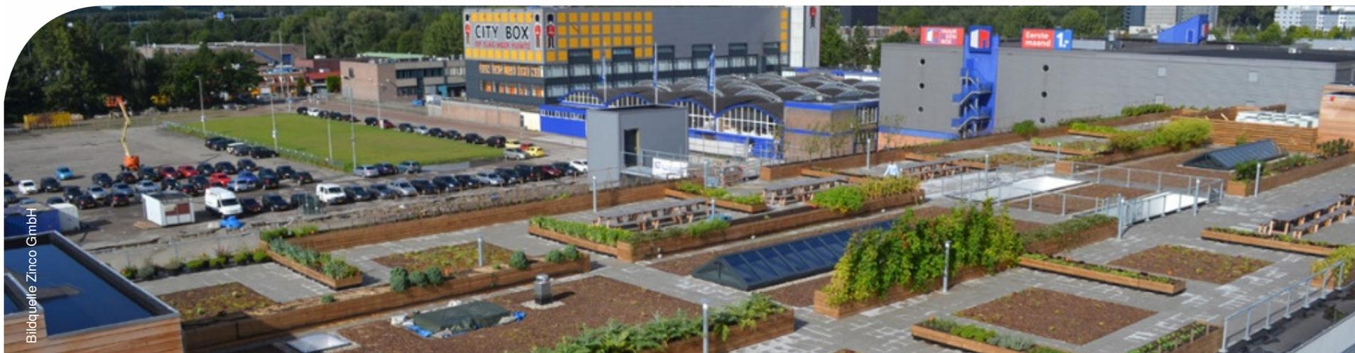
Dachwasser wird zur Verwendung als Gießwasser in Zisternen gesammelt. Bei bituminöser Abdichtung können jedoch Wurzelschutzgifte aus der Dachbahn ausgewaschen werden!
