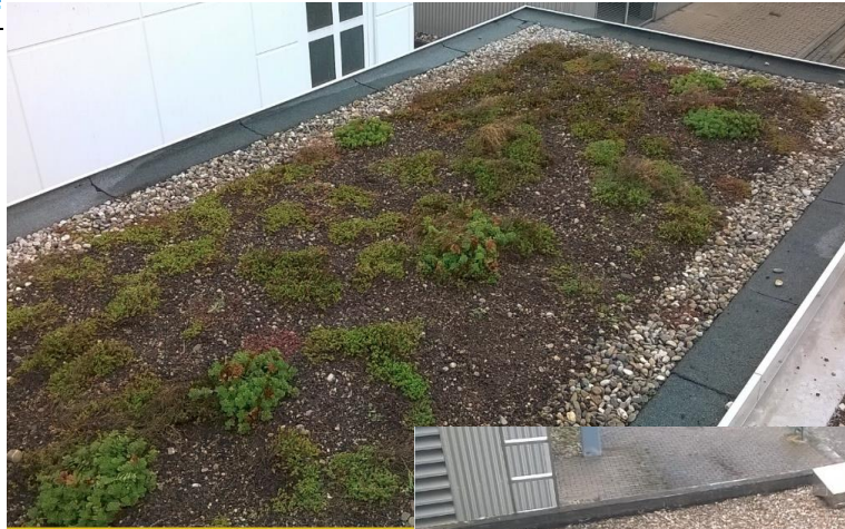
Dach mit extensiver Begrünung
