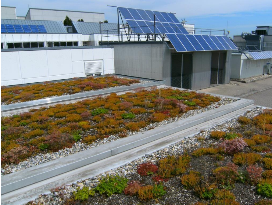
Extensiv begrünte Dächer: Systemerde ca. 9 cm, Begrünung v.a. mit Sedum, Anlage: 2011
