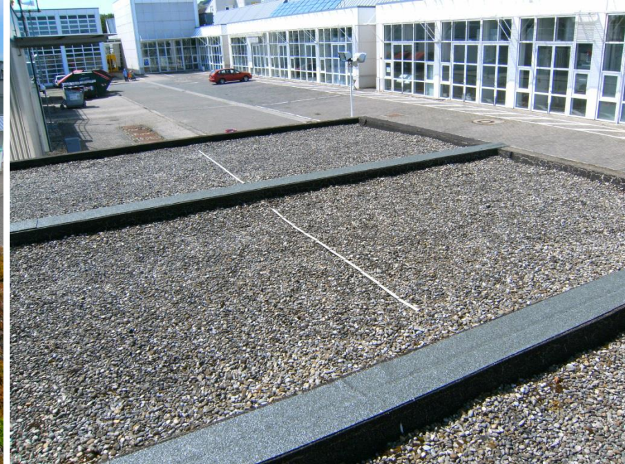
Kiesdächer: Bitumen-Dachpappe und 3 - 5 cm Kiesschicht
