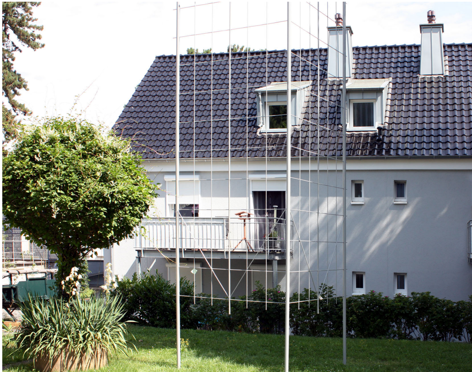
Vorgeständerte Ecke – Probeaufbau
