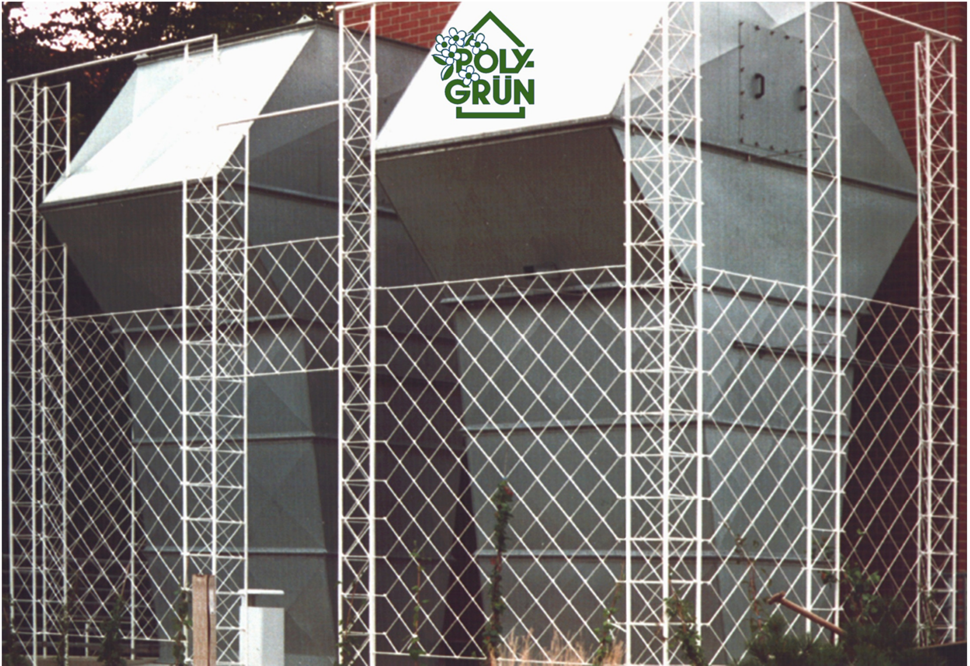
Dachgarten Springer, ca. 1993, Architekt Lutz Volkmann
