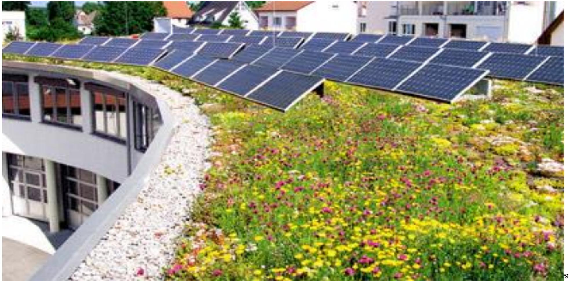
Gründächer erfüllen vielerlei Funktionen, z. B. ihre schützende Wirkung für die Dachabdichtung, ihre Wärmedämmung, ihr Regenwasserrückhalt oder ihre ökologische Ausgleichsfunktion. Nun kommt ein weiterer Nutzen hinzu: die Nutzung der Sonnenenergie zur Stromerzeugung (Photovoltaik) oder Warmwasseraufbereitung bzw. zur Heizungsunterstützung (Solarthermie). Denn Flachdächer gehören im Bezug auf eine Solaranlage zu den dankbarsten Standorten
