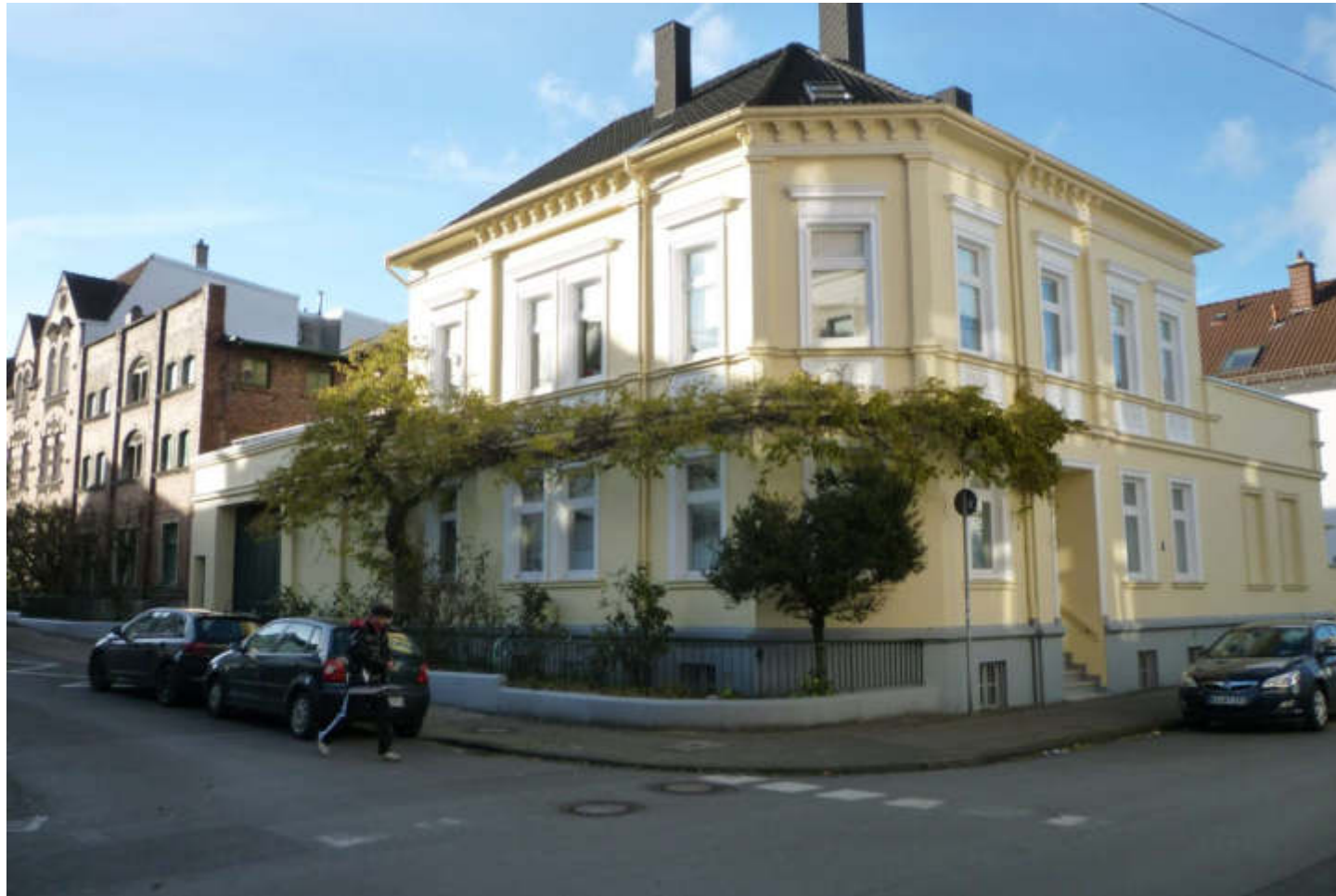
Bodengebundene Fassadenbegrünung mit Glyzinie, Oldentruper Straße
