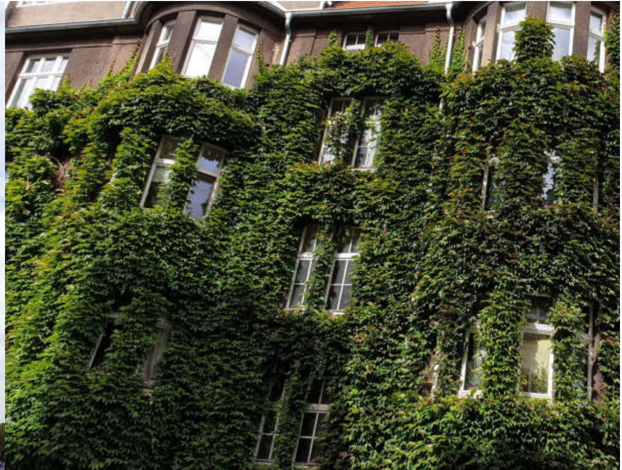
Bodengebundene Begrünung im Straßenraum , Ravensberger Straße
