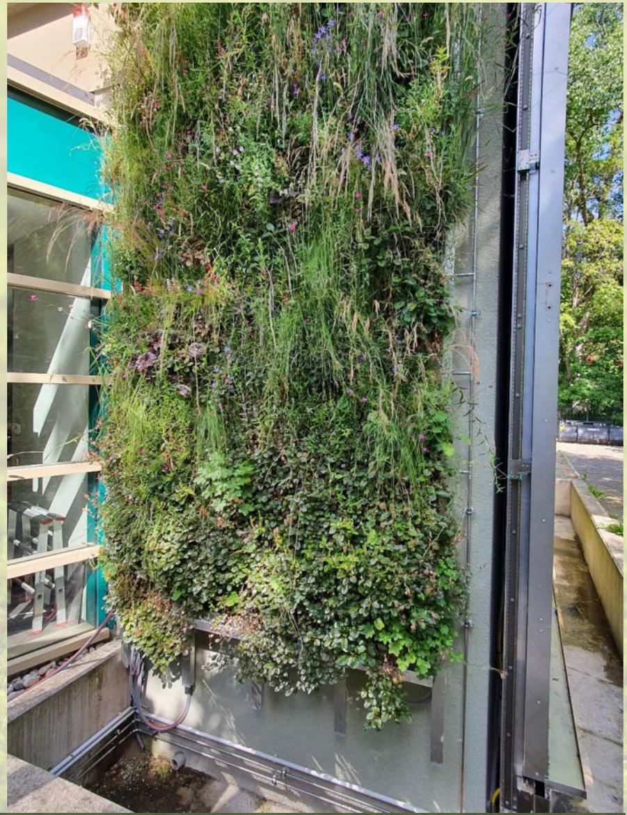
**Testsystem 4 X 2 m der neuen Kassetten-Pflanzwand vom Typ M3**
