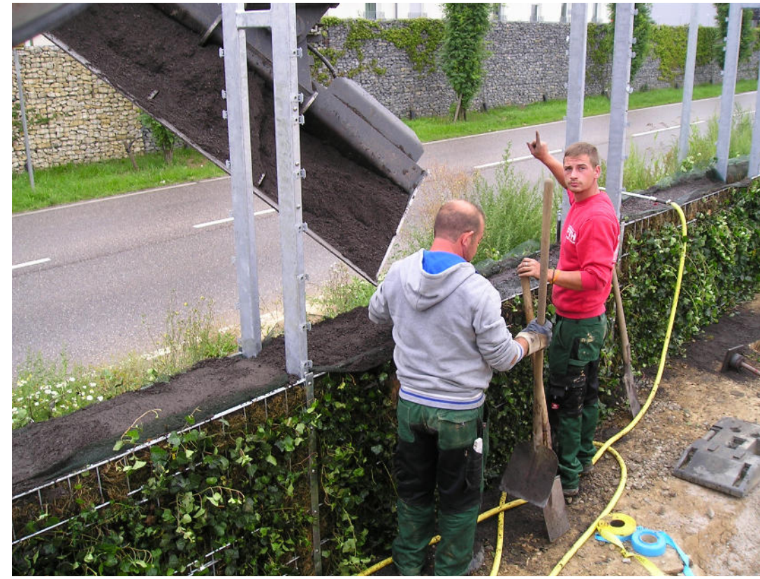
Hinterfüllung mit Substrat
