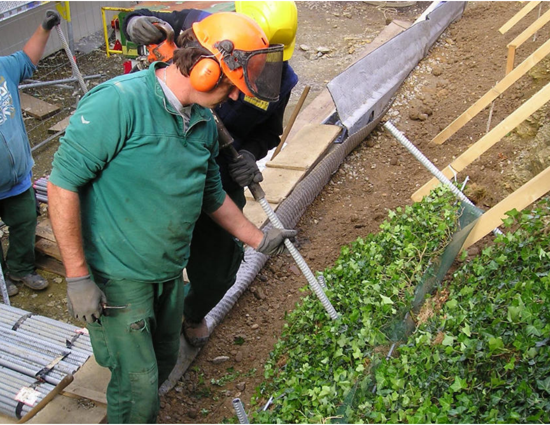
Befestigung der Erdnägel
