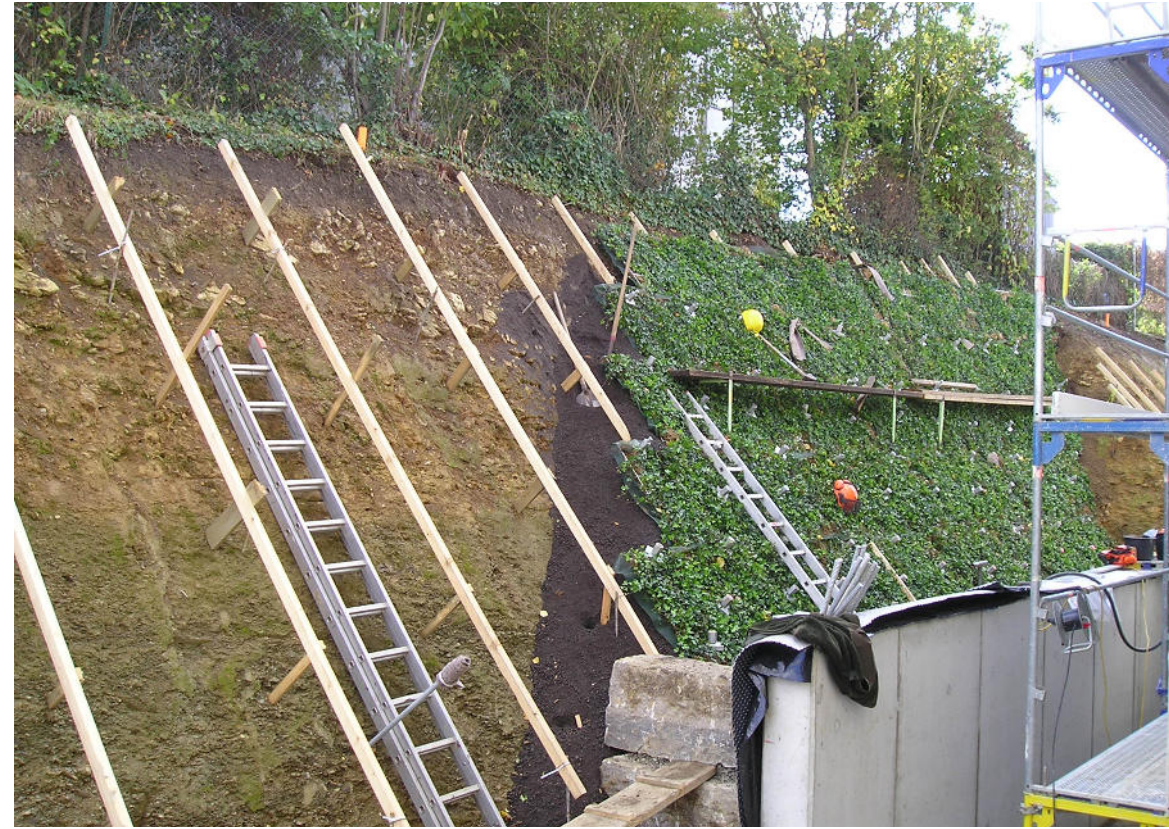
Hinterfüllung mit Substrat
