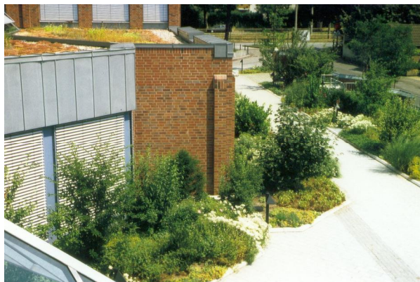
Abb. 3: Intensive Dachbegrünung und eine Parkplatz-Feuerwehrezufahrt. Eine aufwendige Funktionstrennung (Wasseranstau) ist erforderlich.
