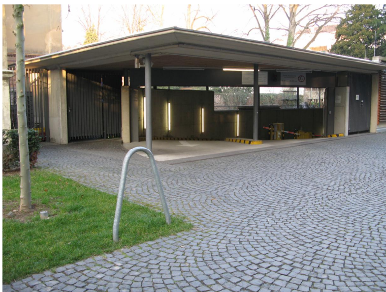
Abb. 4: Technisch anspruchsvoll: Eine Tiefgaragenzufahrt mit Naturstein-Kleinpflaster.
