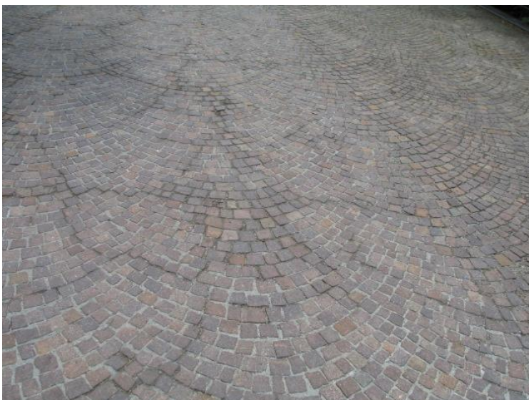
Abb. 7: Gebundene Pflasterbauweisen sind technisch sehr anspruchsvoll.
