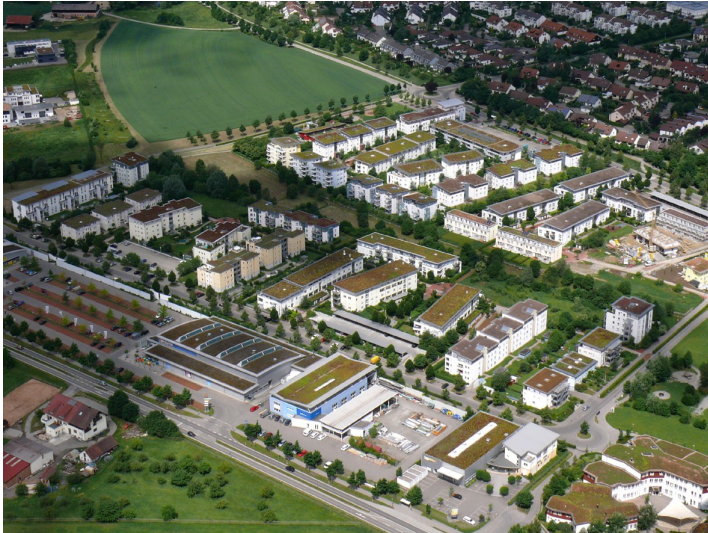
2. Rund 50 Gebäude mit Dachbegrünung im Neubaugebiet „Domäne Hochberg“ in der Ravensburger Weststadt; rechts unten die Freie Waldorfschule
