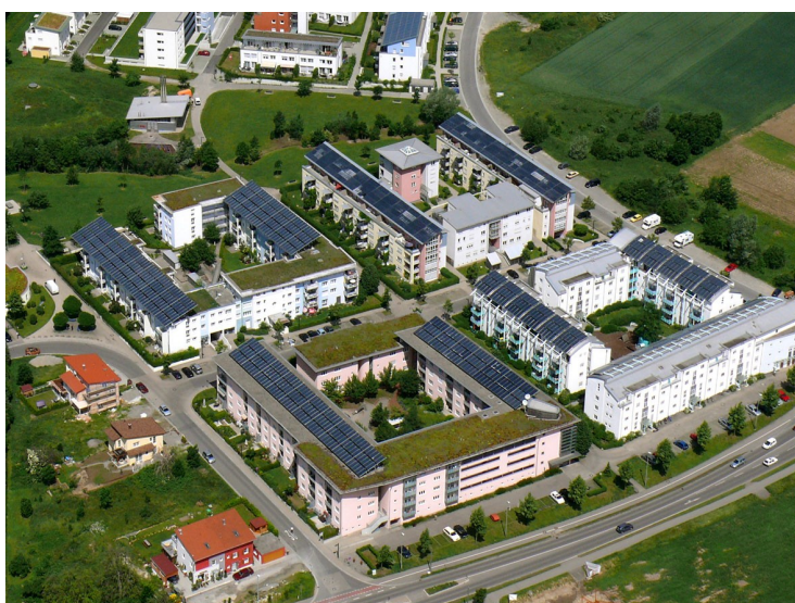
6. Bei diesen Wohnanlagen im Friedrichshafener Stadtteil Wiggerhausen wurden Dachbegrünung und Solarnutzung kombiniert
