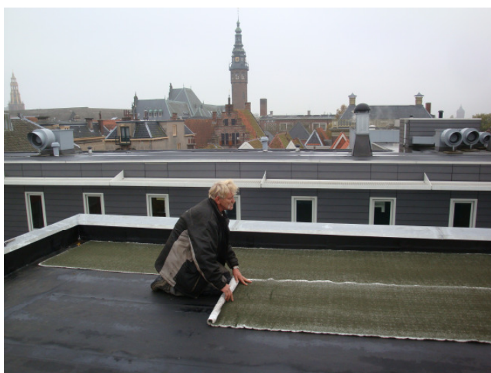
Abb. 2: Verlegung einer Enka Moss Moosmatte.
