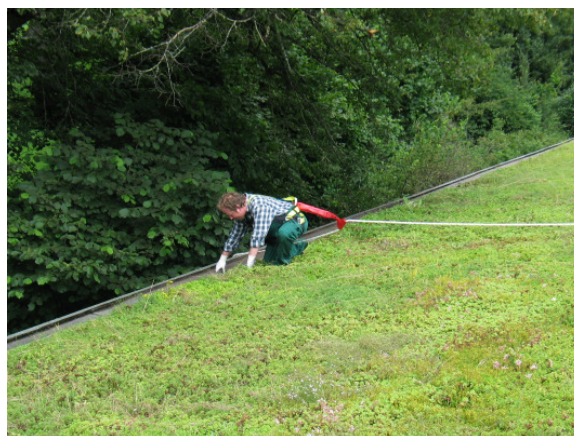
Bild 2: Pflegeeinsatz auf begrüntem Dach unter Einsatz von Persönlicher Schutzausrüstung gegen Absturz.
