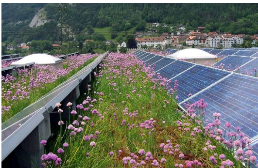
Abb. 5 Verschattung der Module durch ungeeignete Bepflanzung und zu geringe Aufständerungshöhe
