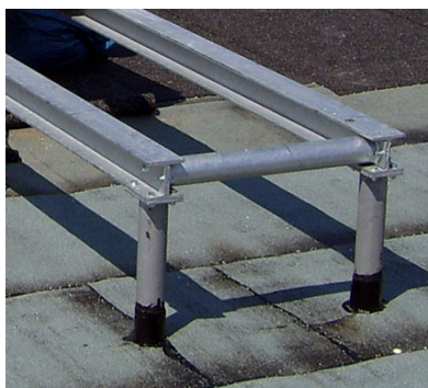
Abb. 2 Dachdurchdringungen zur Montage von Photovoltaikanlagen
