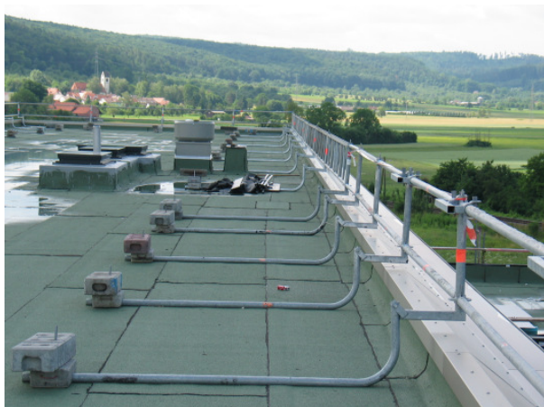
Bild 1: Mobiles Geländer zum Einsatz auf Dachflächen, die nicht umrüstet sind.
