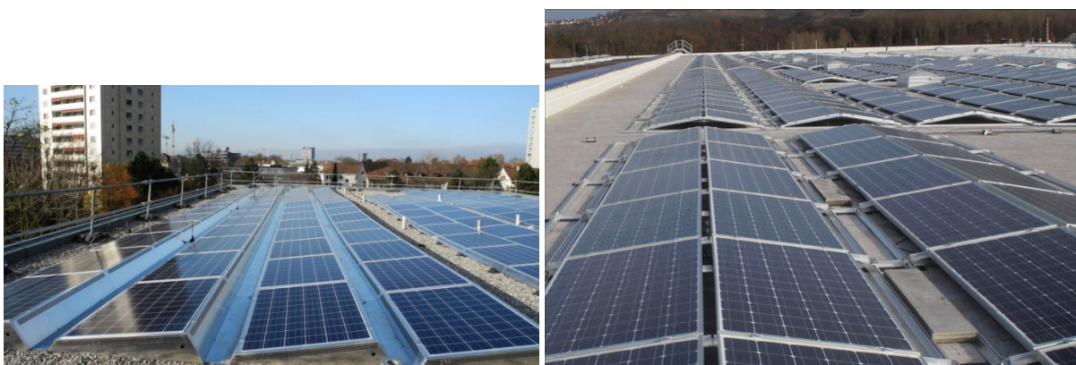
Bild 5 und 6: Kein Platz für „grün“: kostenminimierte Solaranlagen, bei der unter sowie hinter den Panelreihen keine Vegetationstagschicht mehr eingerichtet wird. Foto AUE Basel.
