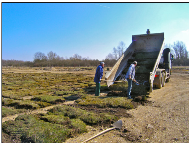
Abb. 4: Flugplatz Oberschleißheim: Soden-Übertrag von einem Kalktrockenrasen als Artenschutzmaßnahme (Quelle: Baader Konzept GmbH)
