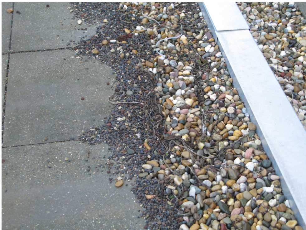
Verfrachtung von Substrat und Sedumsprossen im Kiesrand. Das wird teuer!
