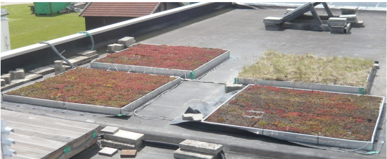
Bild 1: Ansicht der Gründachversuchsflächen auf dem Freilandversuchsgelände des Fraunhofer IBP in Holzkirchen
