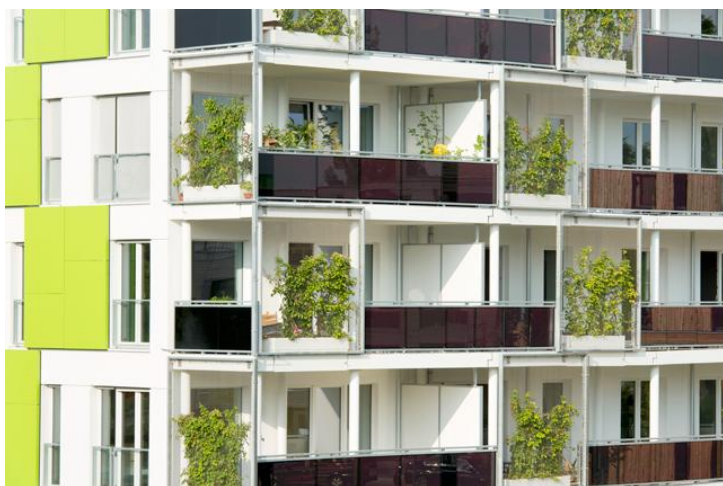
Bild 7: Smart ist Grün - IBA 2013 Hamburg: Feldweise wandgebundene fassadenbegrünung (Kühlung, Teilverschattung, Fassadenbild, Raumbildung, Blickschutz) in Verbindung mit Photovoltaik (Brüstungen der Loggien) (Foto: CHRISTIAN HACKER FOTODESIGN für zillerplus)
