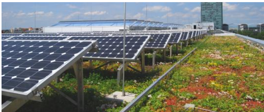
Bild 6: PV-Aufdachanlage: Synergie von Photovoltaik und Verdunstungskühlung durch extensive Dachbegrünung (Foto: ZinCo GmbH)
