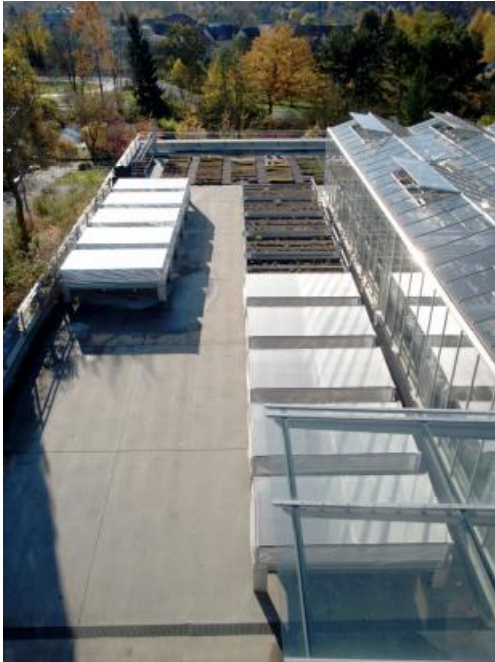
Bild 2: Die Versuchsanlage; rechts vorne die Dächer mit 19% Schattierung, links die Dächer mit 60% Schattierung.
