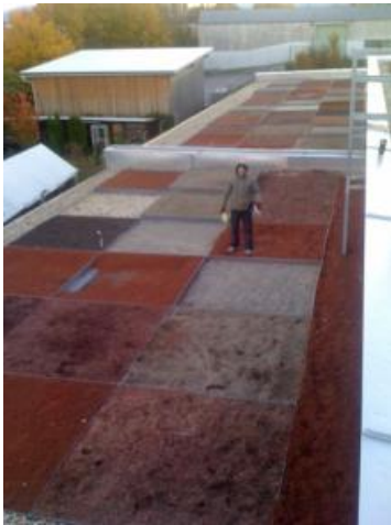
Abbildung 3: Ein Teil der Versuchsanlage am Dach der HBLFA Schönbrunn. Quelle: VFB
