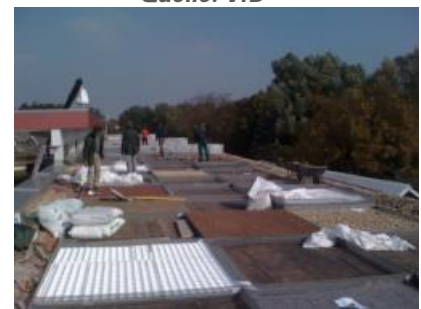
Abbildung 5: Der Einbau der 72 Versuchsflächen. Quelle: VFB
