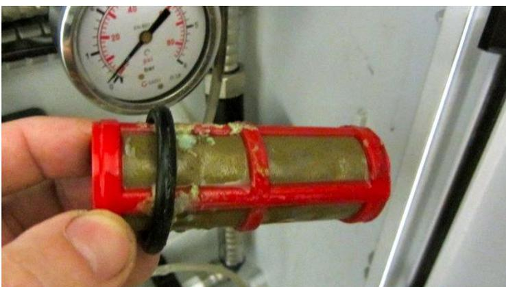
Foto 7: Die Wartung des Bewässerungssystems, hier Reinigung des Filters, gehört auch dazu
