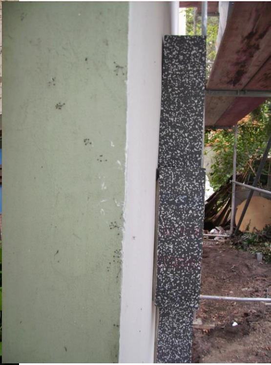
Abb. 3: WDVS wird auf eine Fassade aufgebracht. Dämmstärke 17 cm. Hauseigentümer weigerte sich, die hier vorher existierende Begrünung zu erneuern
