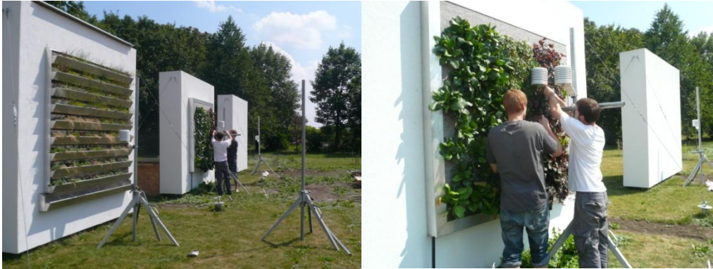
Abb. 17 und 18: Einbau der Messtechnik 08/2011 Quelle: IBLB
