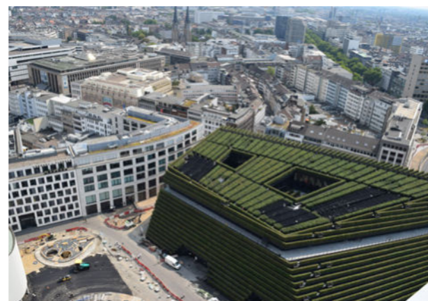
Abb. 2: Dach- und Fassadenbegrünungen sorgen für Verdunstungskühlung und Erhöhung der Luftfeuchtigkeit. Quelle: BuGG
