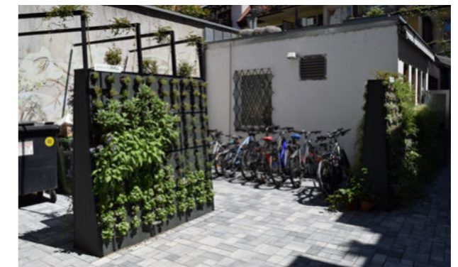
Abb. 32: Hier wurde nachträglich eine begrünte, selbsttragende Wandbegrünung aufgebaut. Quelle: BuGG
