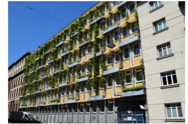
Abb. 28: Wandgebundene Fassadenbegrünung in horizontaler (Regal-)Bauweise. Quelle: BuGG
