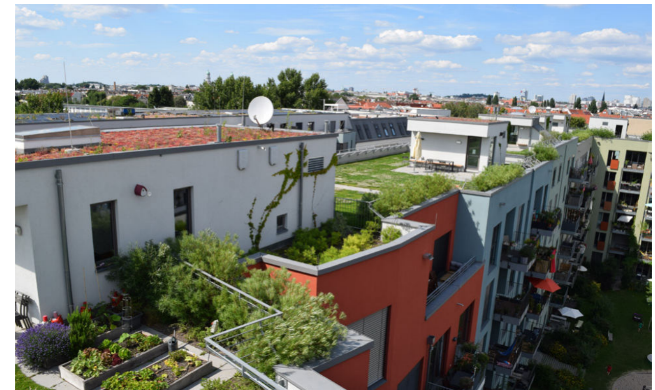
Abb. 13: Extensiv und intensiv begrüntes Mehrfamilienhaus. Nutzung der vielen positiven Wirkungen von Dachbegrünungen. Quelle: BuGG
