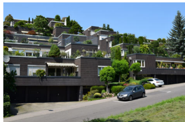
Abb. 40: Intensive Dachbegrünung mit hoher Substratschicht für eine gartenähnliche Gestaltung mit Gehölzen. Quelle: BuGG
