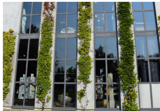
Abb. 23: Bodengebundene Fassadenbegrünung mit Selbstklimmern. Quelle: BuGG
