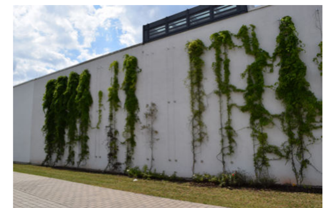
Abb. 49: Die Begrünung solcher Flächen soll gefördert werden. Quelle: BuGG
