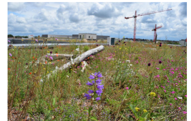
Abb. 38: Dachbegrünungen tragen durch Regenwasserrückhalt und Abflussreduzierung zur lokalen Regenwasserbewirtschaftung bei. Quelle: BuGG
