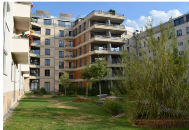
Abb. 21: Retentions Gründach auf einer Tiefgarage. Unterhalb des Begrünungsaufbaus befindet sich der zusätzliche Retentionsraum. Quelle: BuGG
