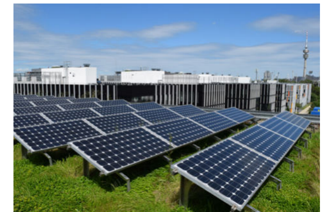
Abb. 17: Praxisbeispiel eines Solar-Gründaches mit Süd-Ausrichtung der PV-Module. Quelle: BuGG
