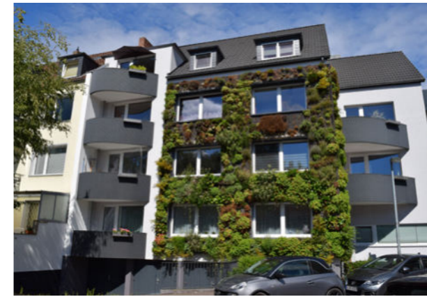
Abb. 26: Wandgebundene Fassadenbegrünung in vertikaler (modularer) Bauweise. Quelle: BuGG
