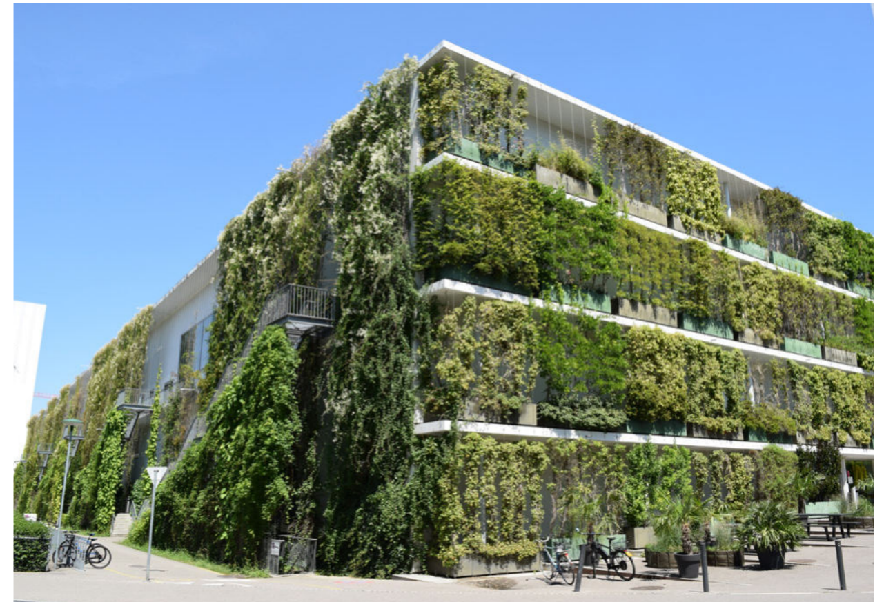
Abb. 22: Boden- (links) und wandgebundene (rechts) Fassadenbegrünung auf einem Foto dargestellt. Quelle: BuGG
