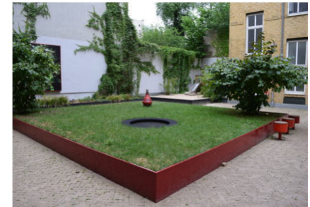
Abb. 10: Innenhofbegrünungen lassen sich auch nachträglich im Bestand schaffen. Quelle: BuGG
