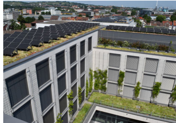
Abb. 6: Zukunftsträchtige Kombination Klimaschutz und Klimawandelanpassung: Solar-Gründächer. Quelle: BuGG
