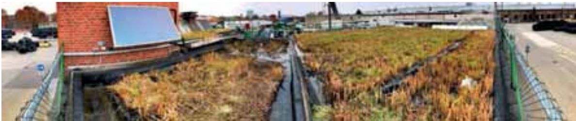
Abb. 1: Sumpfpflanzenkläranlage im John Deere Werk Mannheim; Fotografiert am 21.11.2018 (Fotos: John Deere).
