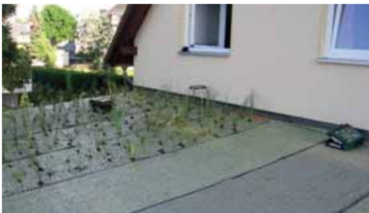
Abb. 4: Aufbau der Dachschichten (Teerpappe, Gewebeplane, später ersetzt durch PVC-Teichfolie, textiler Vegetationsträger) und erste Bepflanzung mit Topfballenpflanzen im August 2008 (Fotos: Mählmann).
