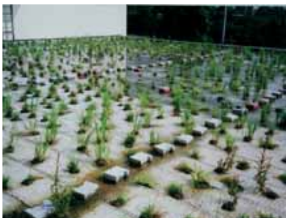
Abb. 1: Flachdach mit Anstauabwässerung und textilen Vegetationsträgern bei Roche Diagnostics, Mannheim (Fotos: Archiv STFI).
