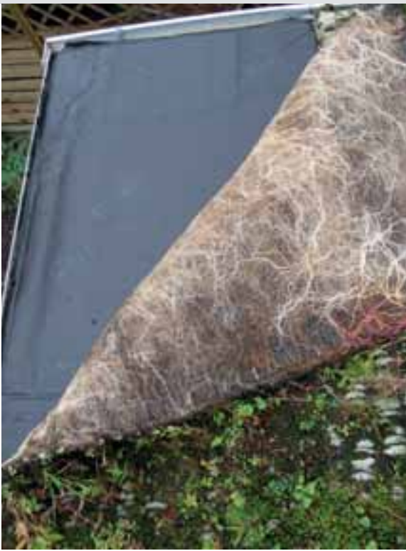
Abb. 10: Die textilen Vegetationsträger bilden mit der aufwachsenden Vegetation einen engen Verbund; hier gut zu erkennen, die bewurzelte Rückseite einer Matte (April 2009) (Foto: Mählmann).
