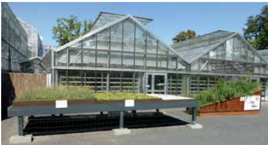
Abb. 4: Sumpfpflanzendach (ganz rechts), extensiv begrüntes Dach (Mitte), Gründach mit regionaler Pflanzenmischung (links) und Kiesdach unmittelbar nebeneinander im Botanischen Garten Leipzig 2017 (Foto: A. Zehnsdorf).
