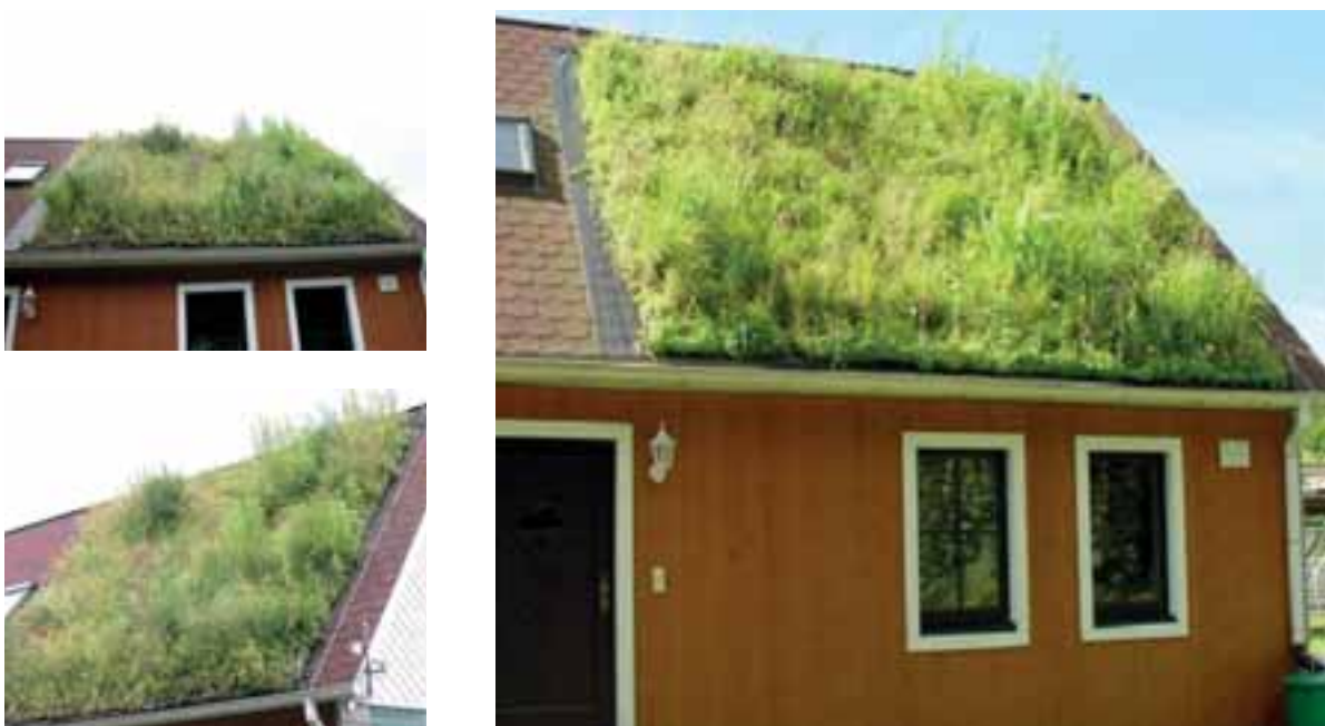
Abb. 3: Schrägdachbepflanzung mit textilen Vegetationsträgern am „Öko-Versuchshaus“ in Hainsberg bei Dresden (Fotos: Archiv STFI).
