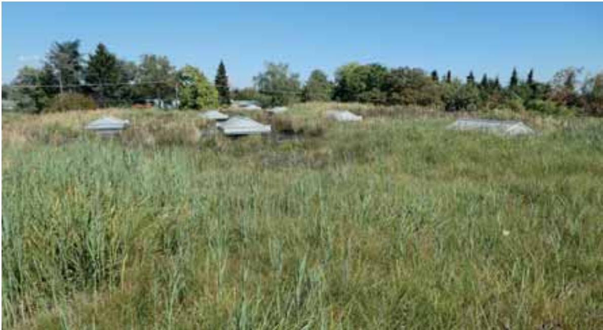
Abb. 4: Sumpfpflanzendach der Firma Possmann in Frankfurt 2018 (Foto: A. Zehnsdorf).
