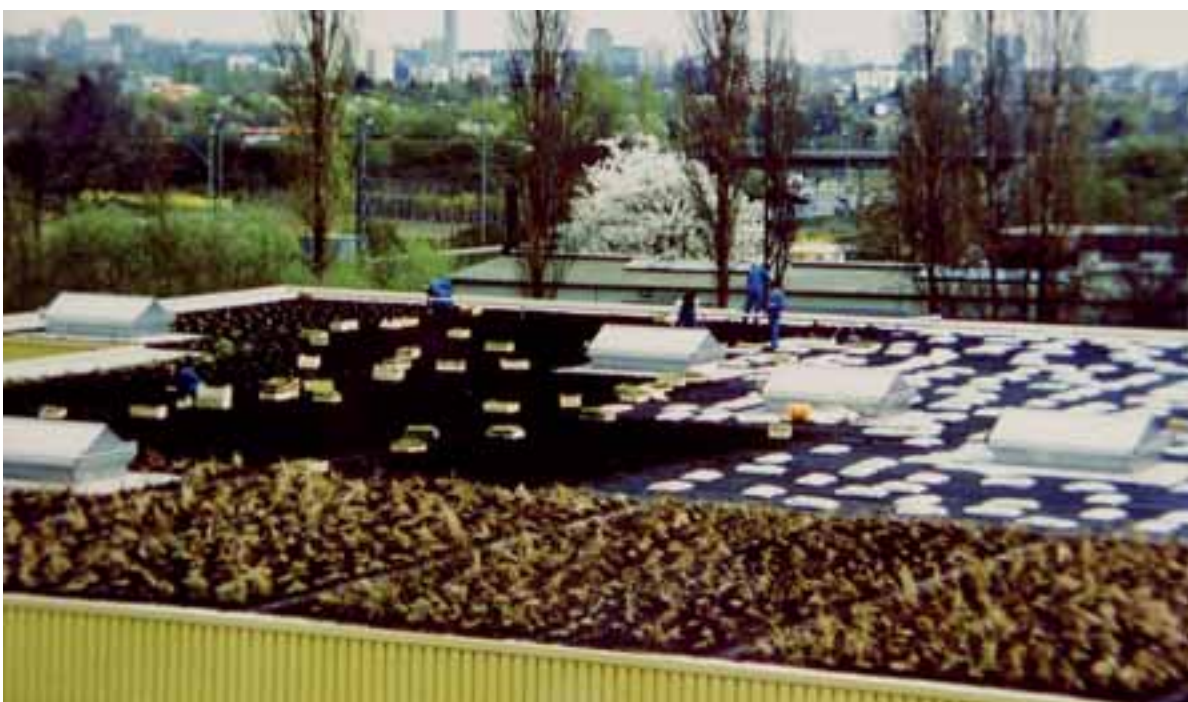
Abb. 4: Aufbau und Bepflanzung des Sumpfpflanzendaches. (Foto: Possmann).
