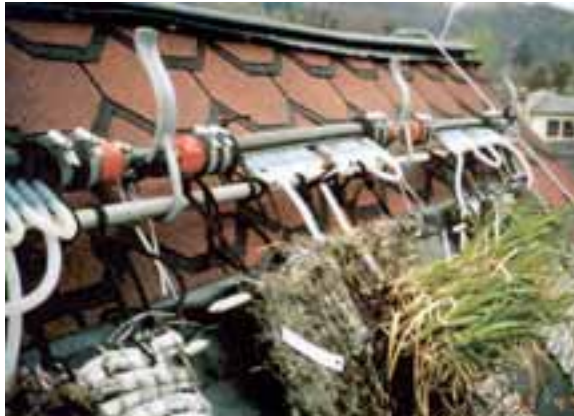
Abb. 3: Befestigung der textilen Vegetationsträger im Firstbereich eines Steildaches (Fotos: Archiv STFI).
