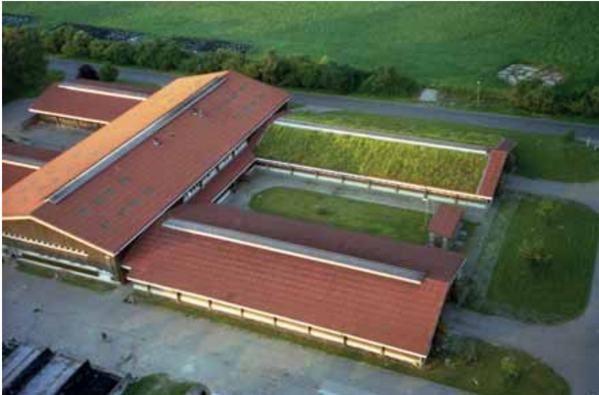
Abb. 5: Milchviehanlage der Versuchsstation Braunschweig der FAL im Jahr 2006. Im Vordergrund je zwei Ställe mit je 60 Kühen, ein Stall begrünt mit einem Sumpfpflanzendach (Foto: H. Georg).
