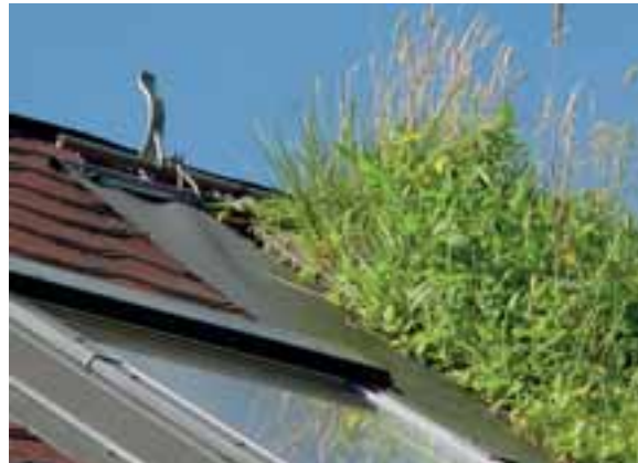
Abb. 3: Befestigung der textilen Vegetationsträger im Firstbereich eines Steildaches (Fotos: Archiv STFI).
