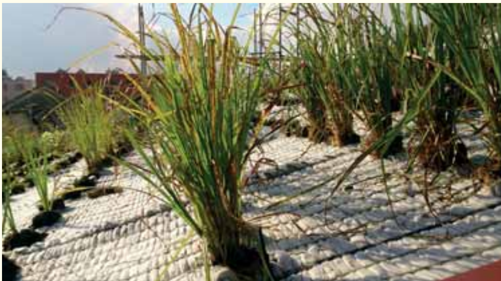
Abb. 9: Das Sumpfpflanzendach in Zofingen kurz nach der Erstbepflanzung durch die Firma Rhizotech (Foto: M. Blumberg).
