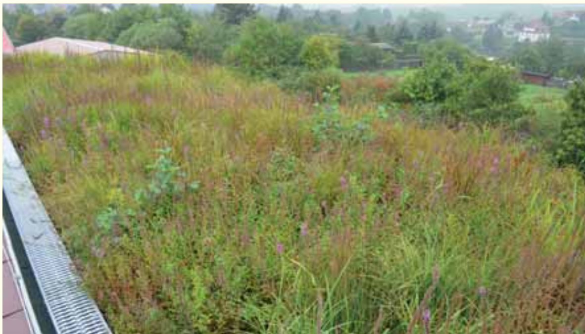
Abb. 5: Sumpfpflanzendach zur Gebäudeklimatisierung (Foto: M. Blumberg).
