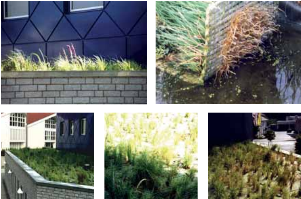
Abb. 2: „Pflanzenklimaanlage“ mittels Flachdach mit Anstaubbewässerung am Beispiel des „blauen Hauses“ in Mülheim an der Ruhr (Fotos: Ulrich Zens).
