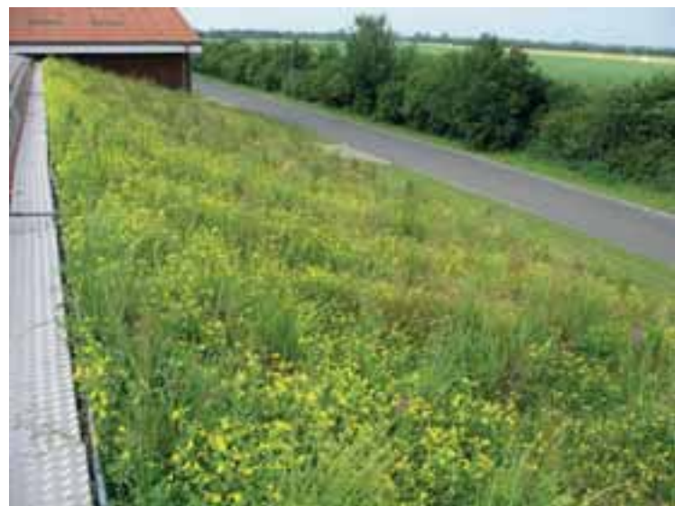
Abb. 4: Sumpfpflanzendach auf einer Dachhälfte des Stallgebäudes (Ostseite) im Juni 2006 (Foto: H. Georg).
