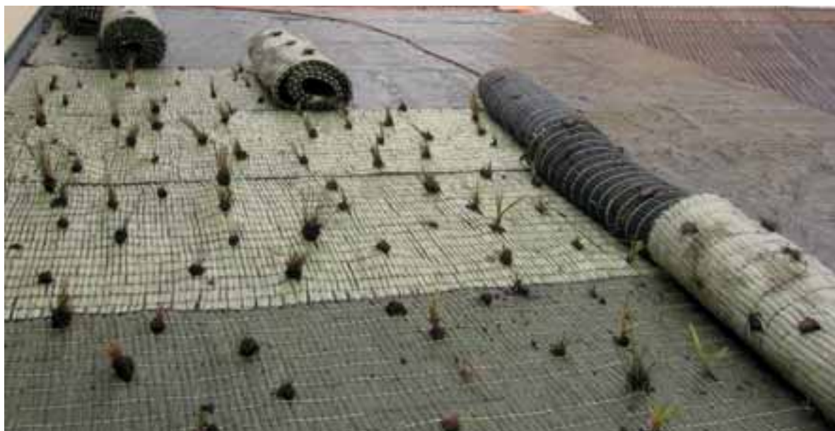
Abb. 9: Austausch der Wurzelschutzfolie (beschichtete Gewebeplane gegen PVC-Teichfolie) im April 2009 (Foto: Mählmann).
