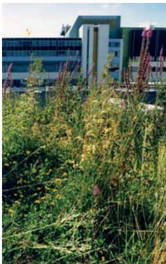
Abb. 1: Flachdach mit Anstauabwässerung und textilen Vegetationsträgern bei Roche Diagnostics, Mannheim (Fotos: Archiv STFI).
