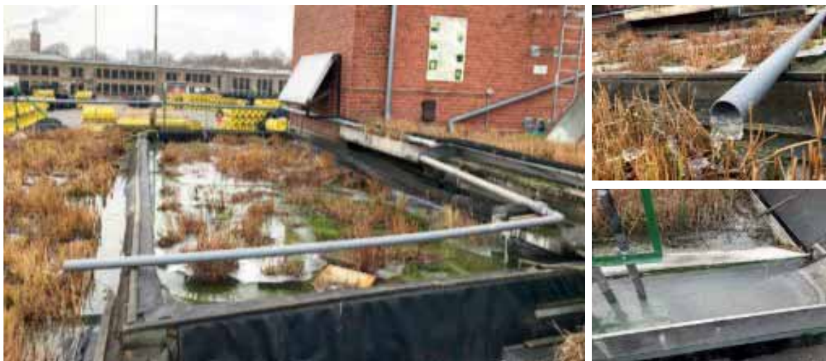
Abb. 5: links: Einstellung des Notfallrohres vom Speicherbecken zum sechsten Becken des Hauptreinigungsbeckens; Fotografiert am 23.01.2019 rechts oben: Das gebildete Eis im Notfallrohr bei Temperatur -1 °C; Fotografiert am 24.01.2019 rechts unten: Das gefrorene Abwasser im Zulaufbecken bei Temperatur unter -1 Grad; Fotografiert am 24.01.2019 (Fotos: John Deere).
