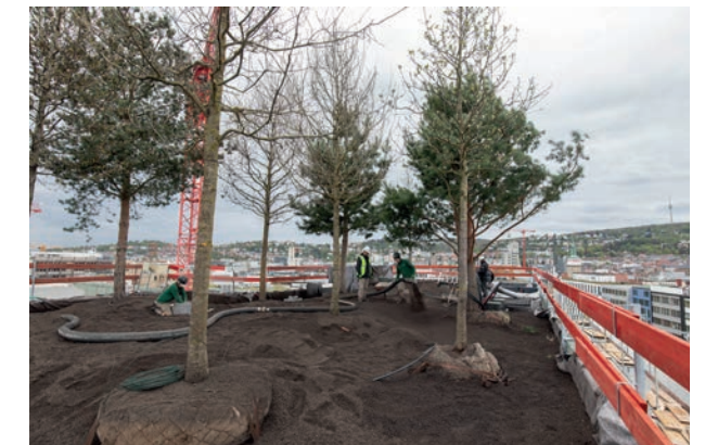
Abb. 2. Verteilung des Substrats auf dem Dach (Quelle: Link Substrat Produktion und Handel GmbH)
