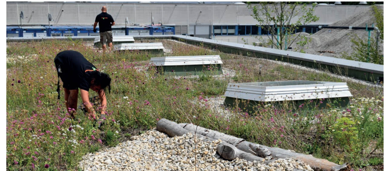
Abb.1. Fachgerechte Instandhaltung als Voraussetzung nachhaltiger Gebäudebegrünungen (Quelle: BuGG)
