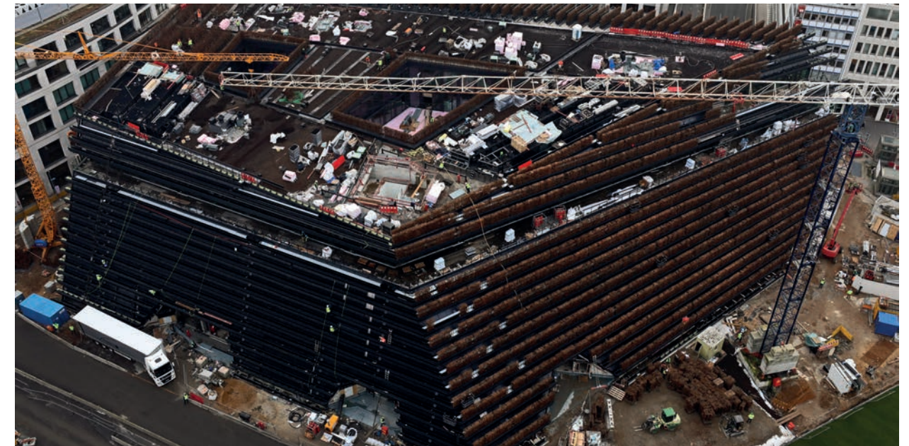
Abb. 1. Der KÖ-Bogen II während der Bauphase (Quelle: Jakob Leonhards Söhne GmbH & Co. KG)
