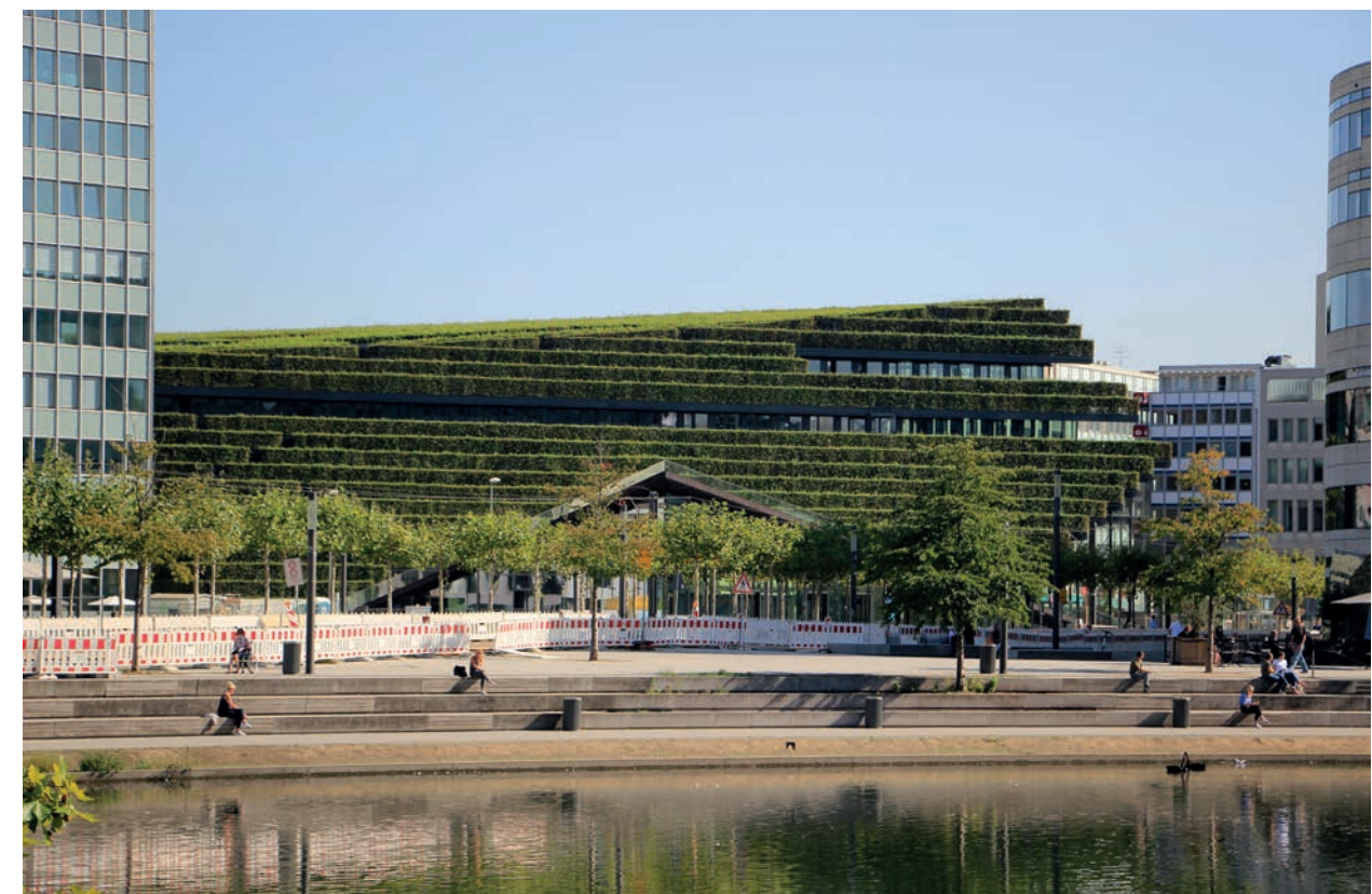
Abb. 1. Dach- und Fassadenbegrünung Kö-Bogen II in Düsseldorf (Quelle: Kathrin Prenger-Berninghoff)
