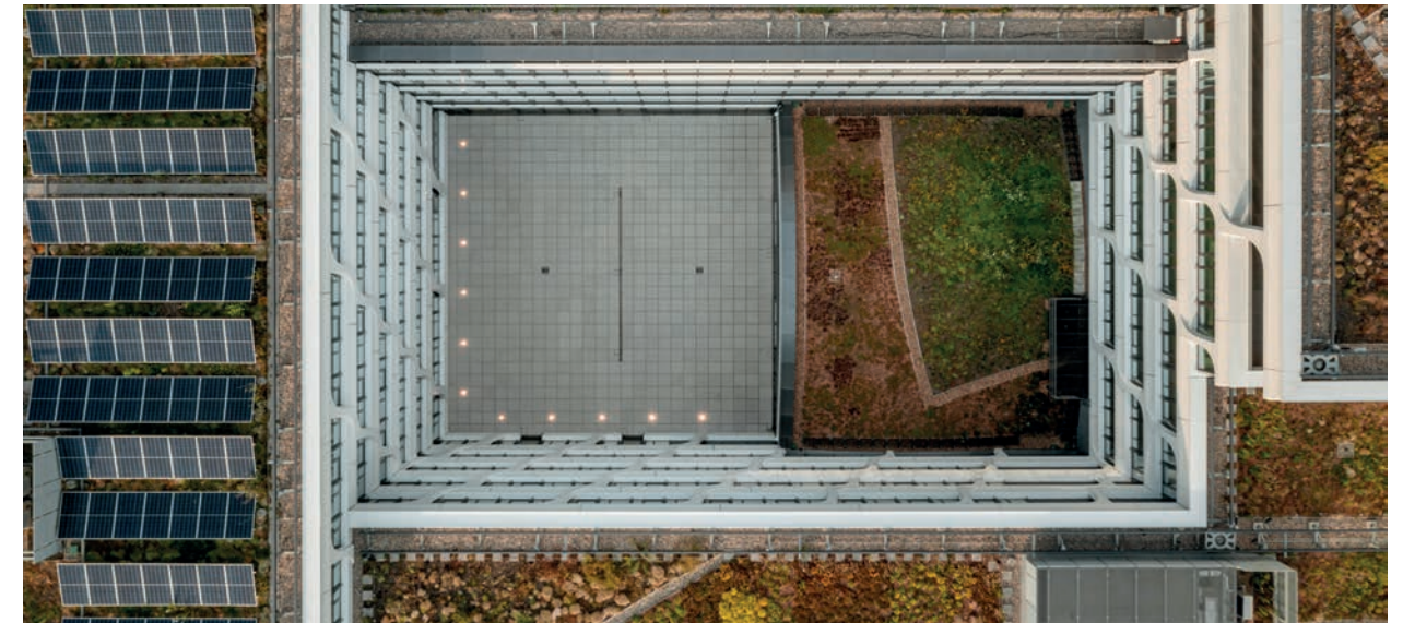
Abb. 1. HeidelbergCement AG in Heidelberg (Quelle: Optigrün international AG)
