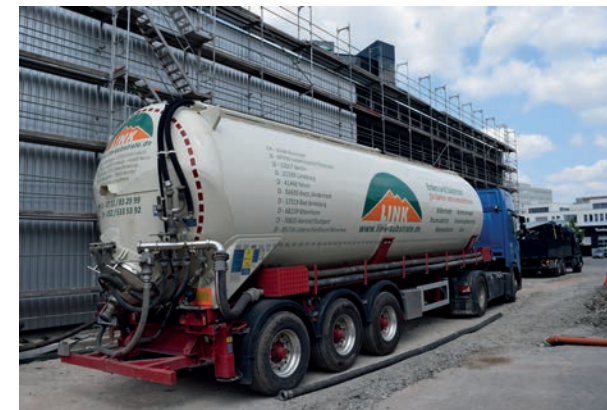
Abb. 1. Anlieferung von Substrat (Quelle: Link Substrat Produktion und Handel GmbH)
